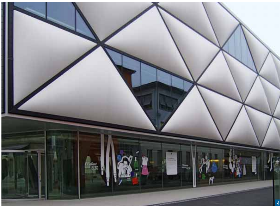
4 Für die Fassaden des Projekts «Miroiterie Flon» in Lausanne wurden dreieckige Membrankissen mit verglasten Bereichen ergänzt.
